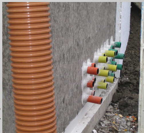
Figur 1. Exempel på applikation med Aquatek Elastic 2C slamning runt plaströr
